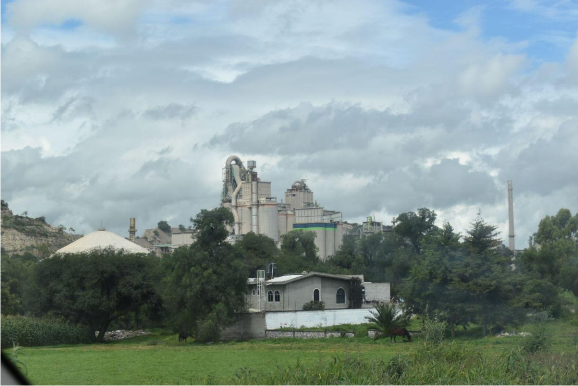
Figura 3. Industria Holcim, planta Apaxco (Fotografía del autor).
